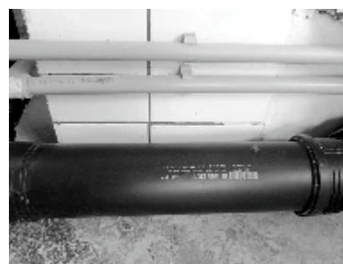
Труби і фітинги для шумопоглинаючої каналізації
