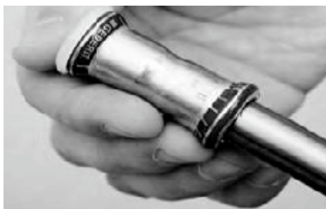
Етап 5 – надягання фітинга на трубу до помітки
