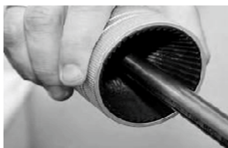
Етап 4 – перевірка ущільнюючого кільця в розтрубі фітинга
